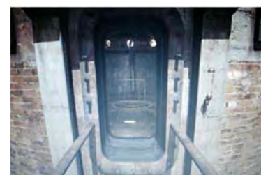
Het mangat in de ketel is nu toegankelijk.
