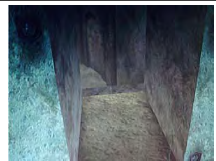
... wordt het water in de ruimtes die leiden naar het inwendige van het rotseiland, weggepompt.
