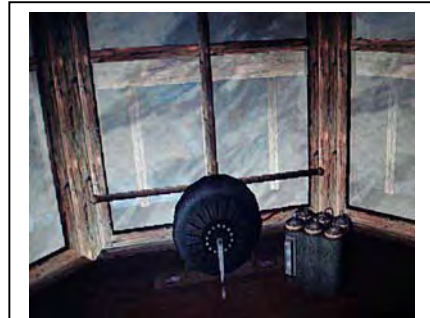
Deze dynamo en zes in serie geschakelde batterijen vormen de energievoorziening hier.
